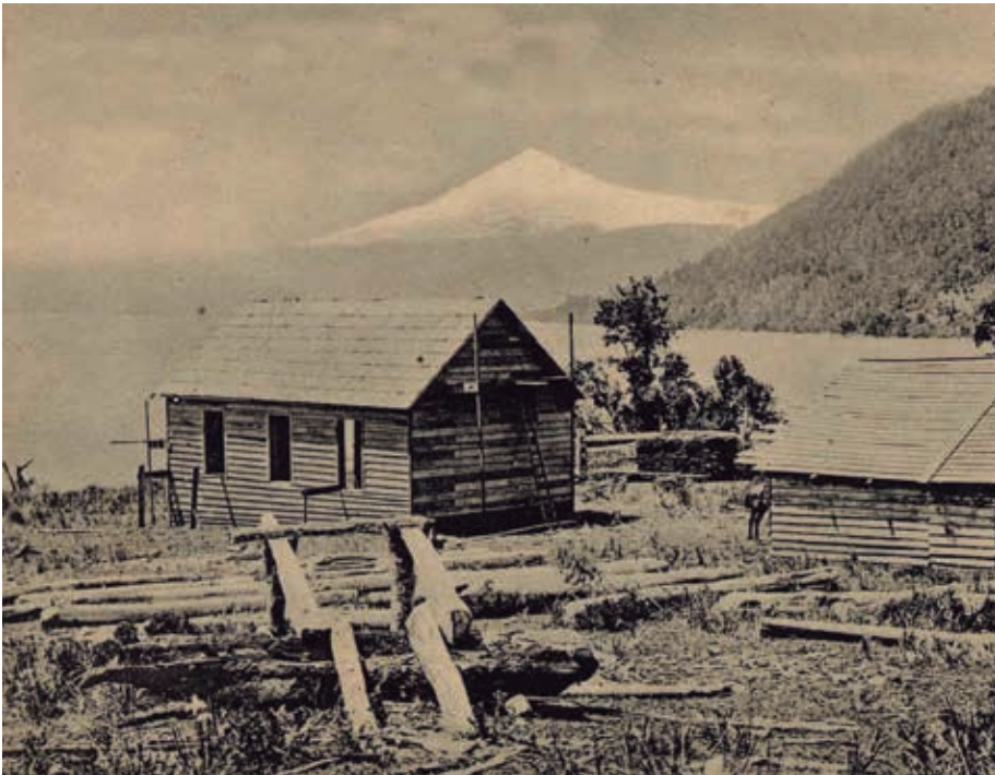
Misión Calafquén. Escuela capilla en construcción. Archivo obispado de Villarrica.
